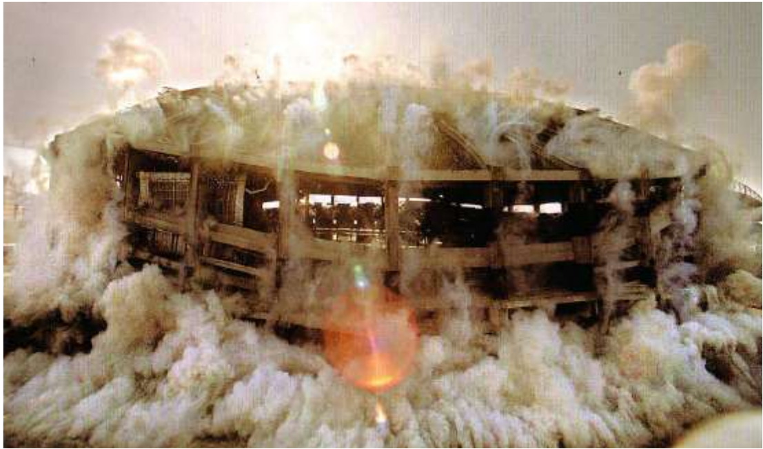
Implosión del estadio deportivo Kingdome de Seattle.
